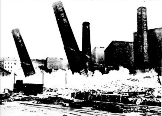
Con el fin de poder iniciar rápidamente las obras de construcción de una nueva fábrica de gas, en Berlín, se destruyeron, por medio de explosiones, las ruinas y chimeneas de una vieja fábrica instantánea nos muestra el momento en que las chimeneas se desplomaban.
